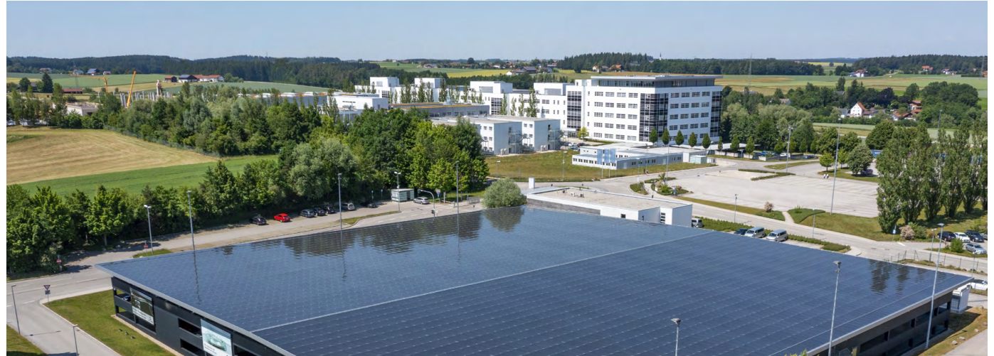
Energie durch Sonnenkraft auf dem Parkdeck am Headquarter in Vilsbiburg
